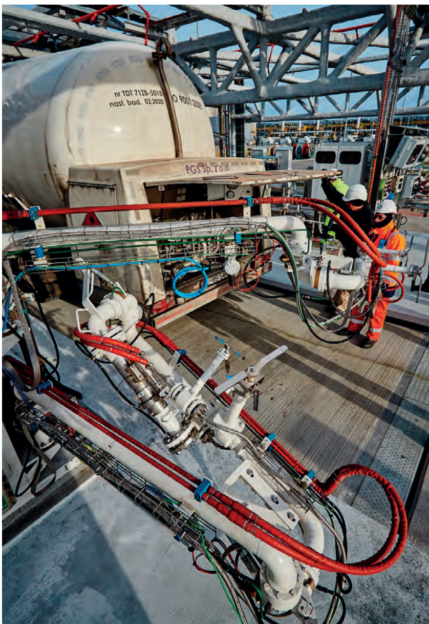
Fot. arch. Polskie LNG S.A.
