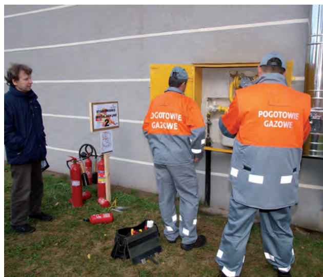
Stanowisko instalacyjne. Fot. arch. MSG
