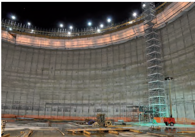
Ściany pierwszego zbiornika. Fot. Zbigniew Gręda
