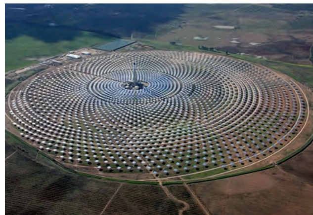
Rys. 1. Elektrownia słoneczna Gemasolar w Seville Źródło: torresolenergy.com
