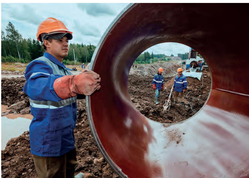
Rura do budowy gazociągu, ze szwem wzdłużnym i wewnętrzną powłoką epoksydową [4]
