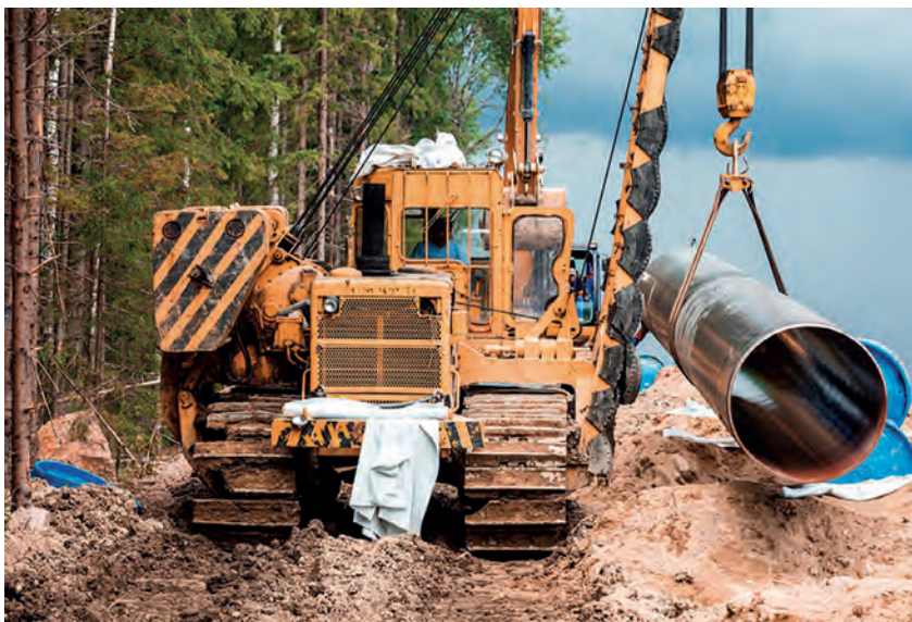
Transport rur na placu budowy gazociągu [4]
