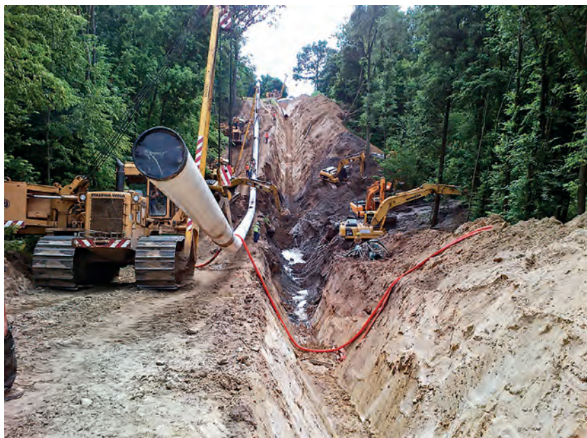
Budowa gazociągu w terenie leśnym [4]
