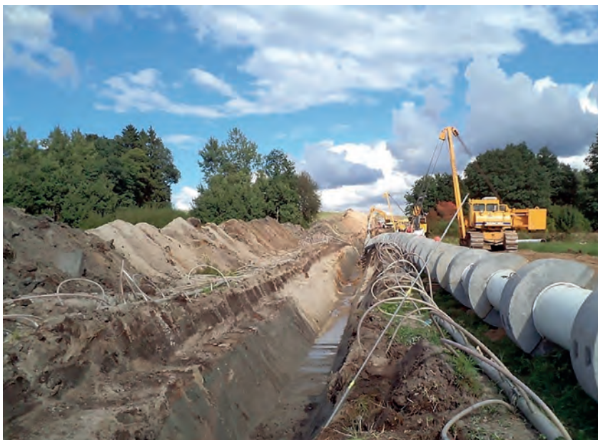
Budowa gazociągu w terenie nawodnionym z zastosowaniem obciążników pierścieniowych [4]
