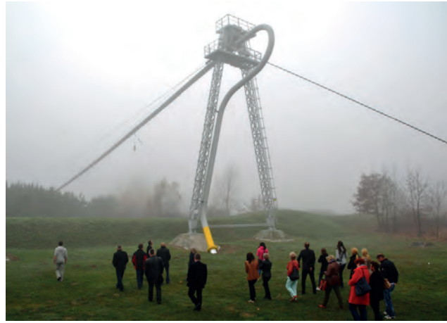
Nadziemne przekroczenie rzeki w Karnatach. Fot. Sylwia Jarczyńska
