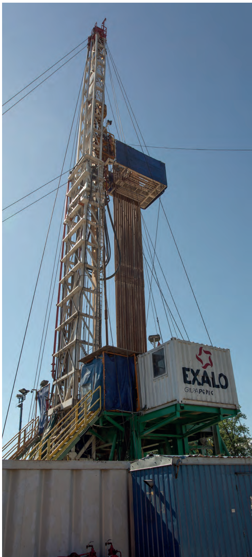
Urządzenie wiertnicze Drillmec MR-8000. Fot. K. Korona
