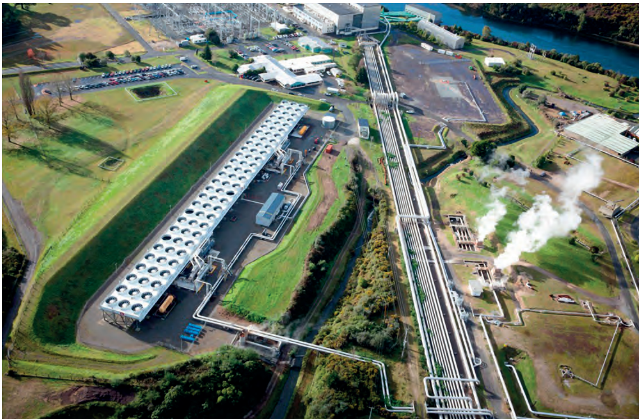
Fig. 1. Elektrownia geotermalna Wairakei w Taupo (Nowa Zelandia) (źródło: Contact Energy)
