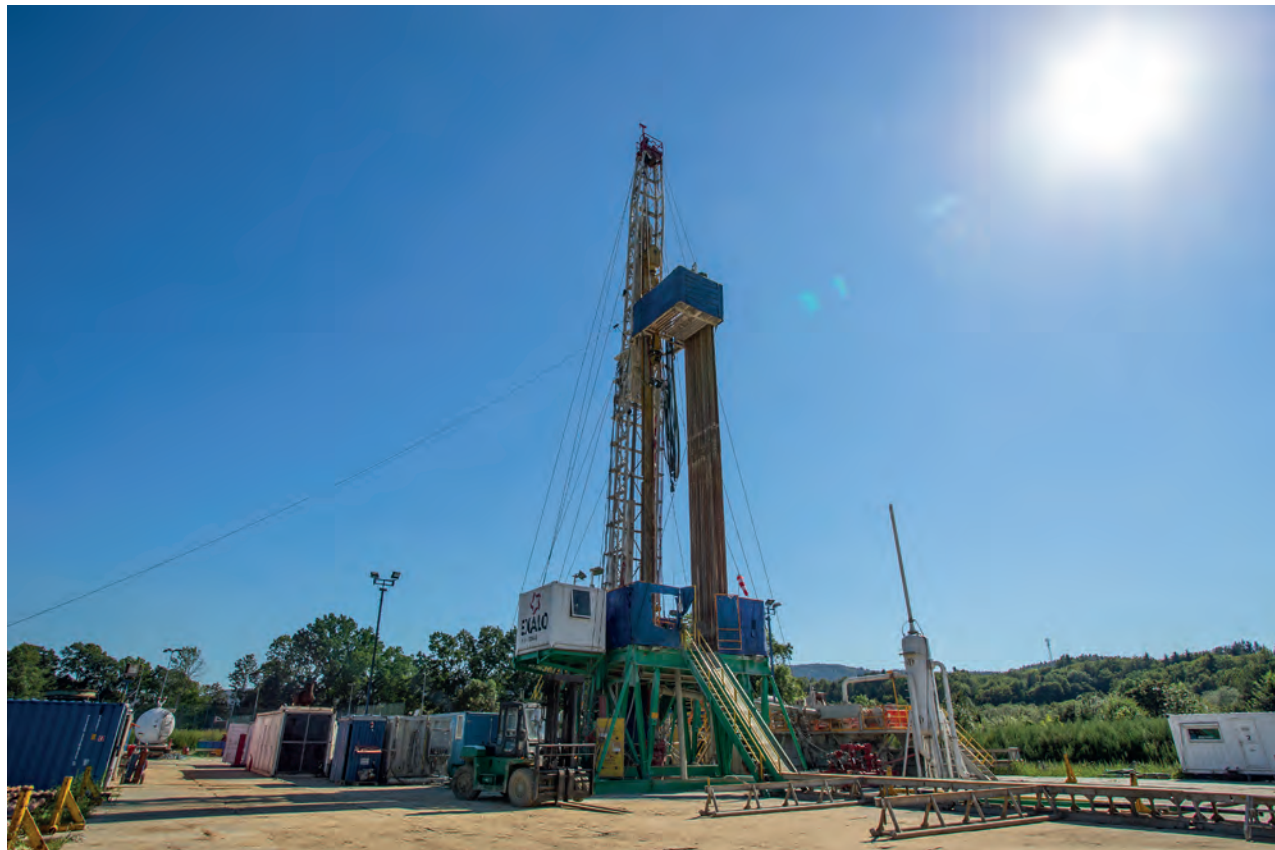
Urządzenie wiertnicze Drillmec MR-8000. Fot. K. Korona
