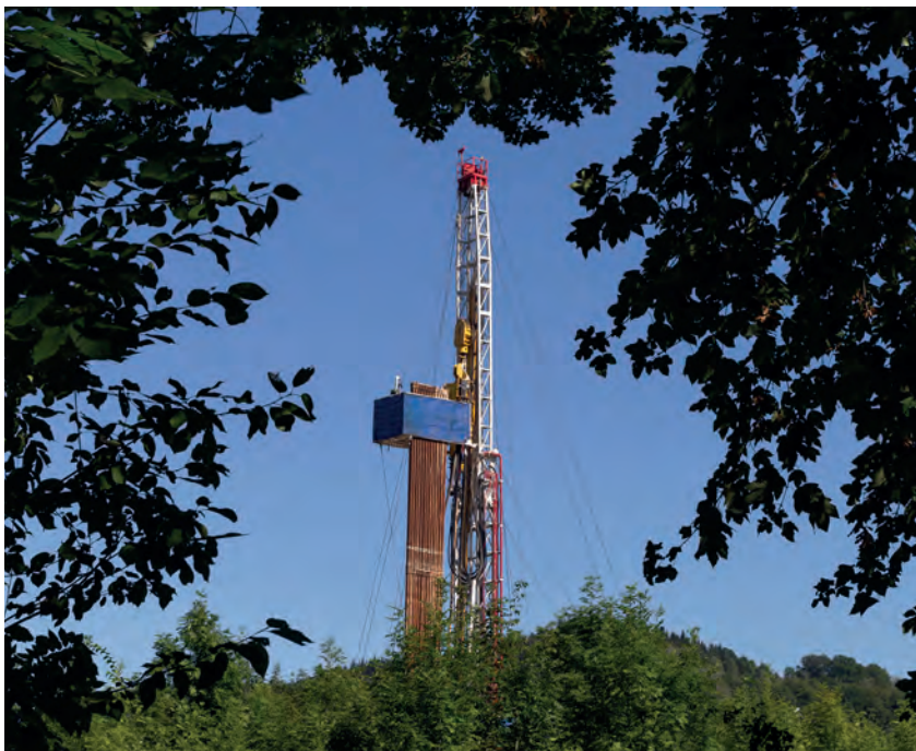
Urządzenie wiertnicze Drillmec MR-8000. Fot. K. Korona
