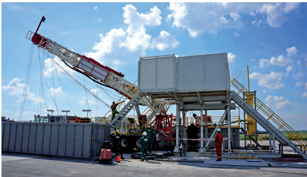
Maszty w górę. Fot. arch. Exalo Drilling S.A.
