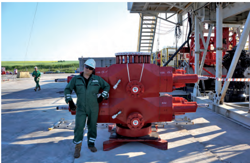
Prewentery już na miejscu. Fot. arch. Exalo Drilling S.A.
