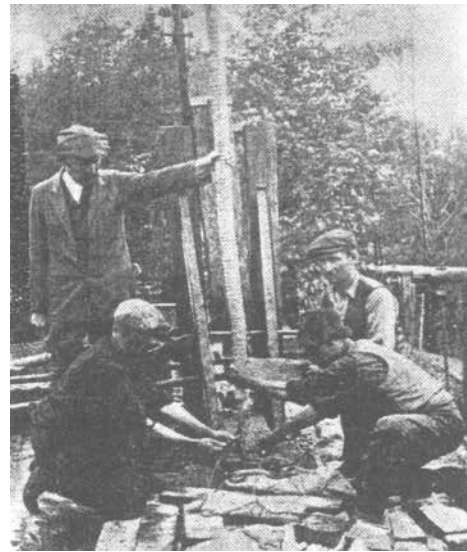
Zapuszczanie torpedy elastycznej. (Historia przemysłu naftowego. T 1, s. 275)
