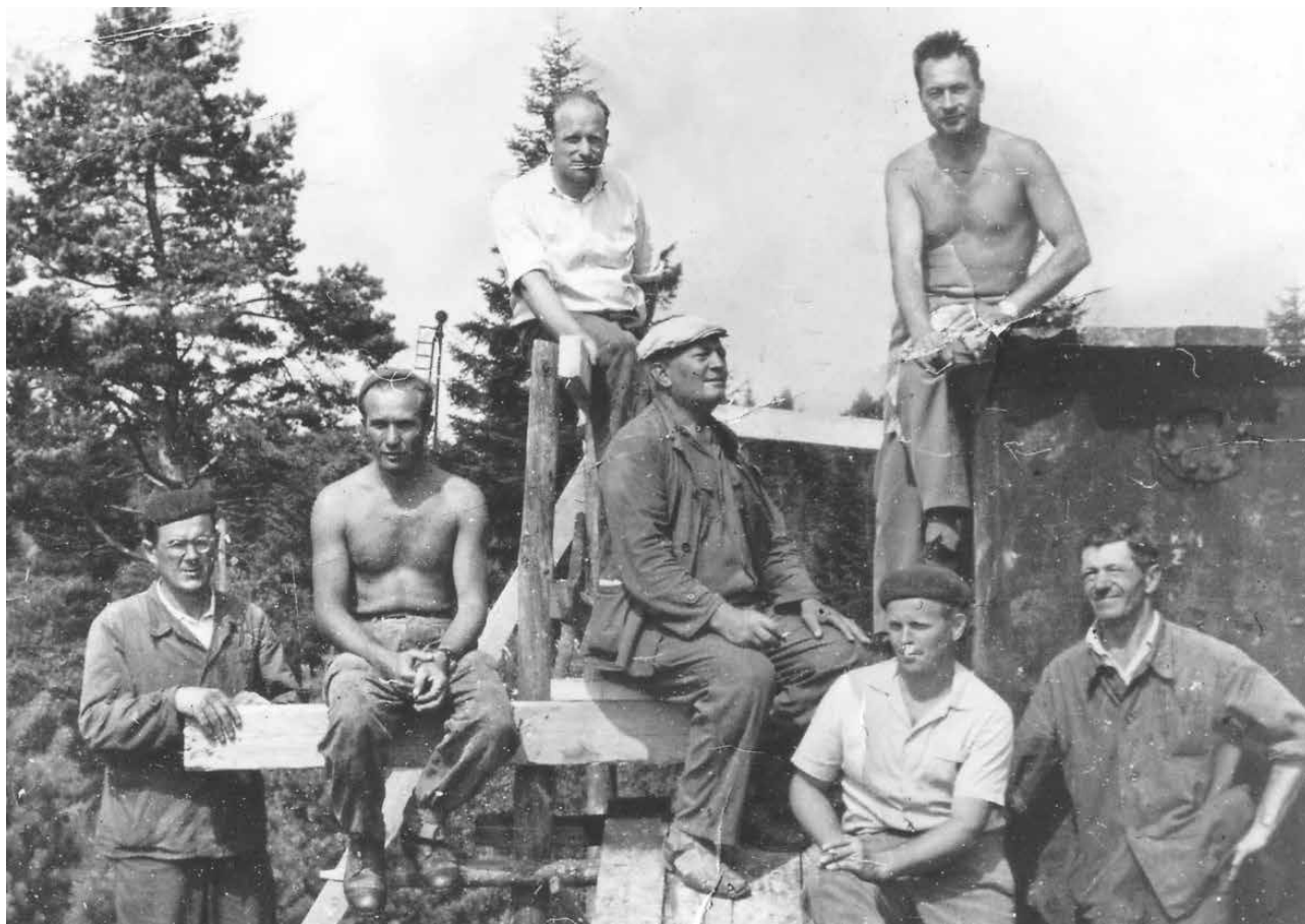
Kierownik kopalni Czarna Jan Kordyś (bez koszuli na zbiorniku) z brygadą budowlaną (fot. arch. W. Turzański)
