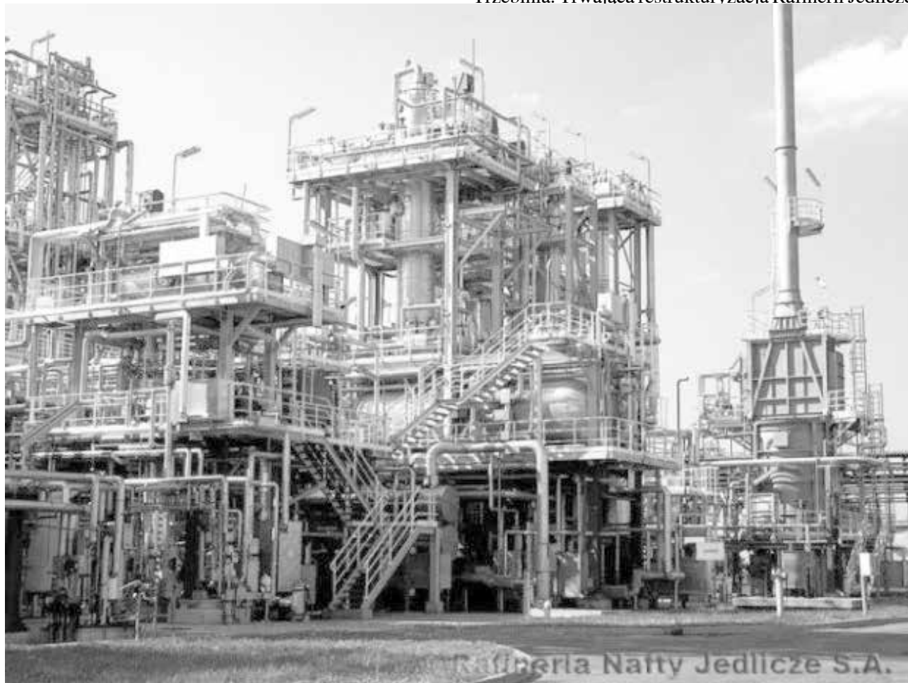
Fot.1. Hydrowy rafinacja olejów z regeneracji (fot. ze zbiorów autora).
