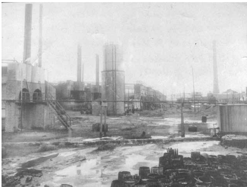
Fot 4 – Destylacja Kotłowa (stara –asfaltowa) rok ok. 1920 (fot. ze zbiorów autora).
