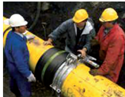
Fot. 2. Zastosowanie hydraulicznej obejm wyoblającej na rurze d630mm
