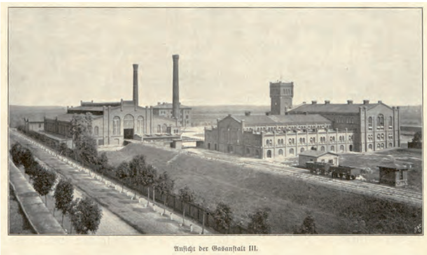
Ansicht der Gasanstalt III.
