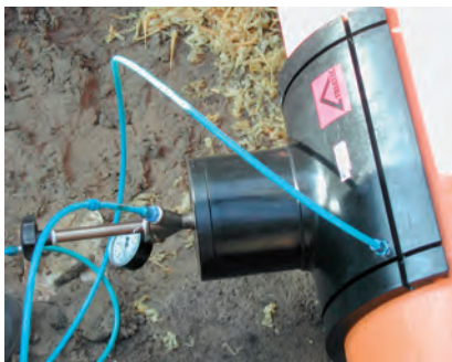
Fot. 12. Montaż siodła SA-XL d315/160
