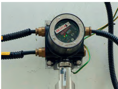
Jednym z systemów zabezpieczeń przed wybuchem, pożarem na Terminalu Ekspedycyjnym Wierzbno jest system detekcji gazu DETRONICS – detekcja heksanu i tlenu w przestrzeni między płaszczowej zbiorników magazynowych ropy naftowej. Fot. arch. PGNiG SA Oddział w Zielonej Górze
