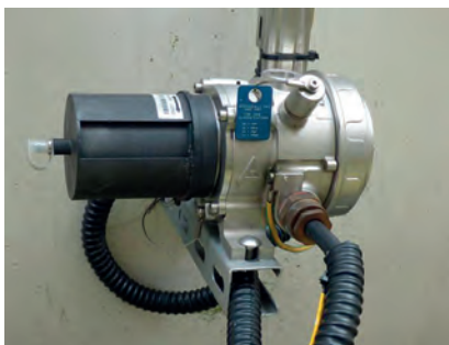
Jednym z systemów zabezpieczeń przed wybuchem, pożarem na Terminalu Ekspedycyjnym Wierzbno jest system detekcji gazu DETRONICS – detekcja heksanu i tlenu w przestrzeni między płaszczowej zbiorników magazynowych ropy naftowej. Fot. arch. PGNiG SA Oddział w Zielonej Górze
