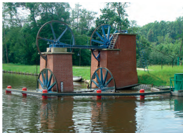
Fot. 4. Koła zwrotne poruszające wózki za pomocą lin. Fot. A. Olszacki
