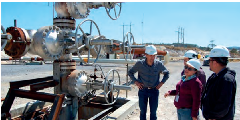
Wizyta naukowców z International Geothermal Centre (Niemcy) w polu geotermalnym Los Humeros w celu wymiany doświadczeń dot. wykończenia otworów geotermalnych. Fot. Michał Kruszewski
