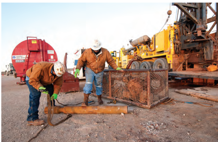
Pakowanie sprzętu i narzędzi przy użyciu klatki i wciągacza jest szybkie. Klatkę można łatwo załadować na płaską naczepę i przewieźć się w inne miejsce. Fot. arch. Atlas Copco Polska Sp. z o.o.
