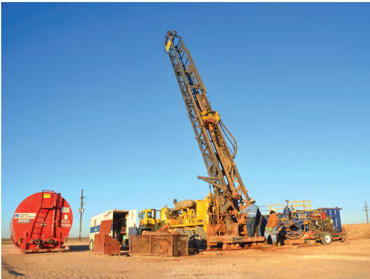
Widok terenu wierceń. Fot. arch. Atlas Copco Polska Sp. z o.o.
