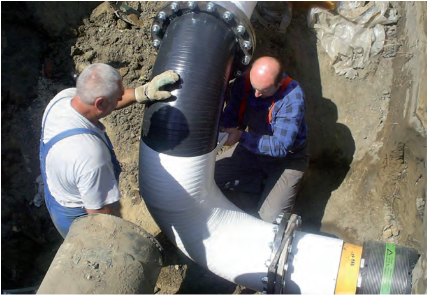
Izolowanie nowego gazociągu. Fot. arch. WSG
