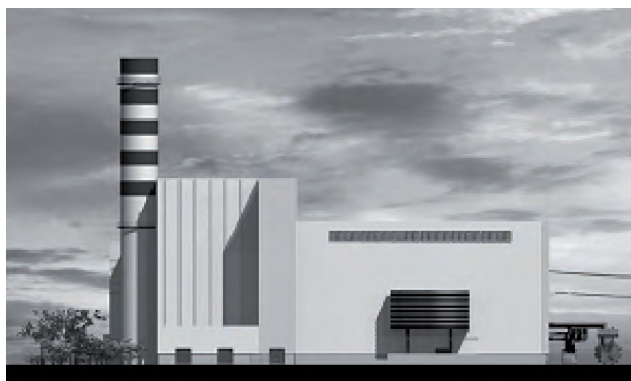
Elektrociepłownia Stalowa Wola. Źródło: PGNIG S.A.
