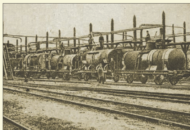
Cysterny kolejowe podczas załadunku (fot. arch. MPNiG w Bóbrce)
