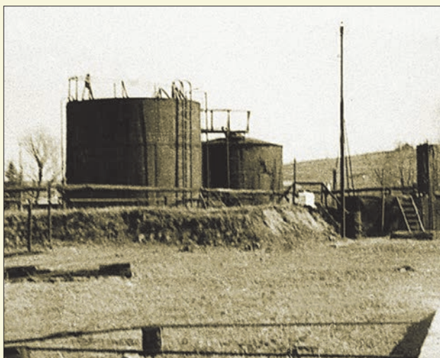
Zbiorniki magazynowe ropy na kopalni Równe (arch. MPNiG w Bóbrce)
