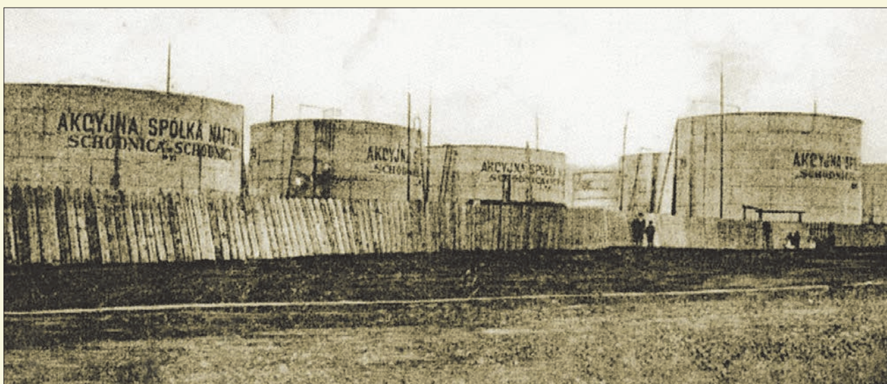
Park zbiorników magazynowych w Schođnicy (arch.MPNiG w Bóbrce)
