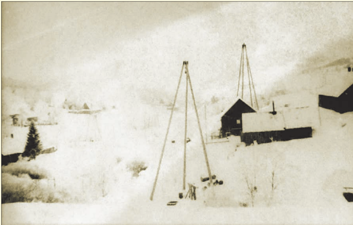
Kopalnia w Ropiance lata 30. XX wieku, z lewej świerk przy domu kierownika kopalni inż. Romualda Postępskiego (zdz. 2)
