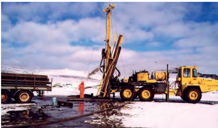
Fig. 1. Mobilna wiertnia z systemem węgłnego młotka powietrznego, przystosowana do małośrednicowych wierceń geotermalnych (Thorhallsson i in., 2016)
