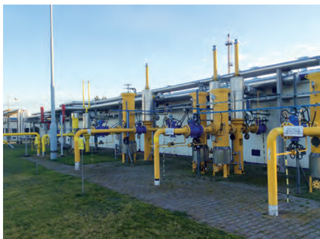
Układy przygotowawcze gazów wsadowych. Fot. archiwum Oddziału
