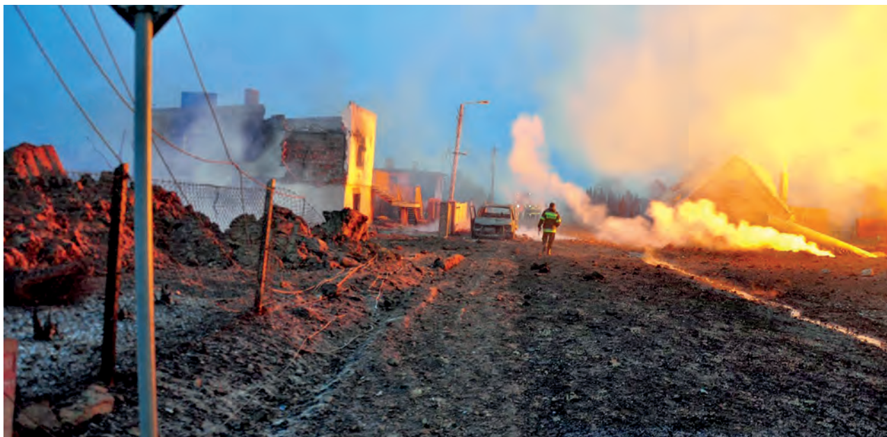
Fot. 1. Widok po katastrofie budowlanej spowodowanej pęknięciem gazociągu przesyłowego w Jankowie Przygodzkim . ( http://www.tvn24.pl ). Fot. Mateusz Nele
