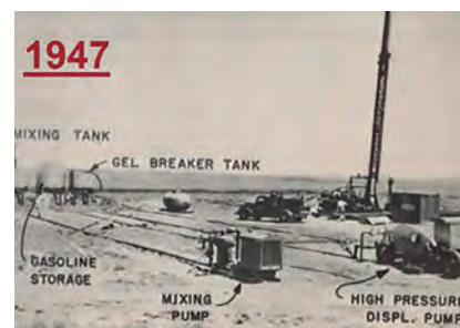
Rys. 2 Pierwsze szczelinowanie hydrauliczne na złożu Hugoton w U.S.A w 1947 r. Źródło: www.cuadrillaresources.com
