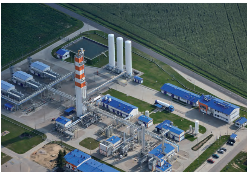
Instalacja Odazotowni Grodzisk powstała w celu wykorzystania dużych zasobów gazu zaazotowanego podgrupy Ls i gazów pozasystemowych w rejonie Grodziska Wlkp., Babimostu i Międzyzochdu. Fot. Paweł Chara
