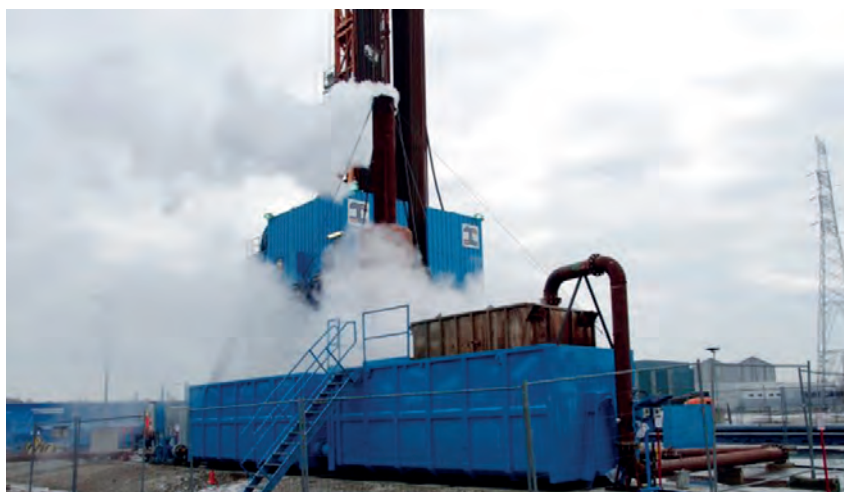
Fot. 3. Wiertnica podczas głębieńienia otworu geotermalnego projektu Balmatt. Źródło: vito.be
