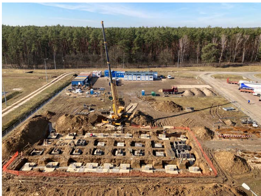
KRNiGZ Dębno. Tu powstanie m.in. nowa instalacja aminowa. Fot. Rafał Sedlaczek
