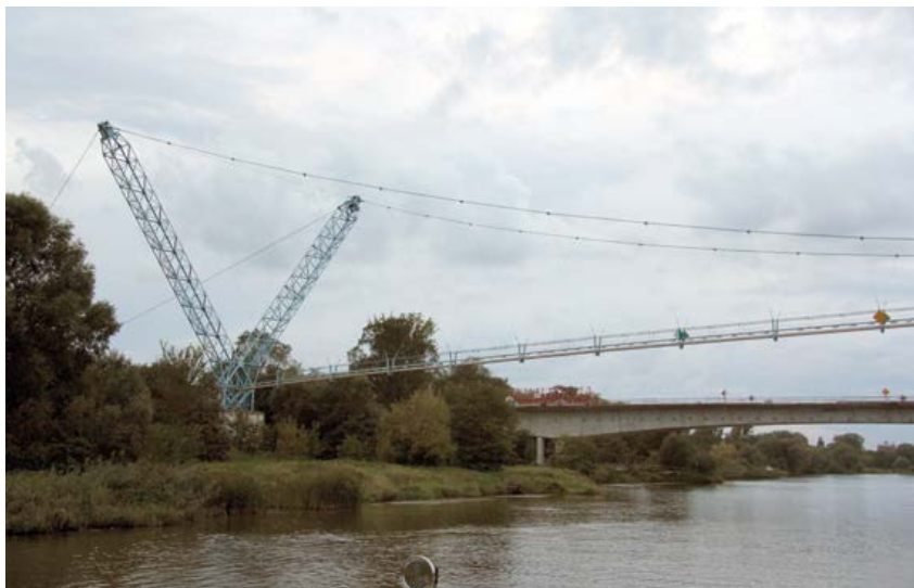
Przekroczenie gazociągiem Odry. Fot. Ryszard Ryba
