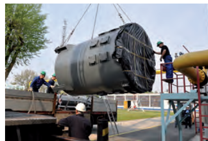
Rysunek 8. Rozładunek segmentów pieca
