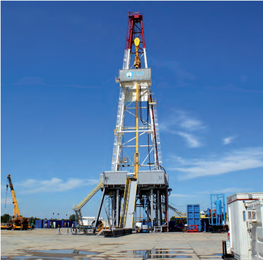
Fot. arch. PNIG JASŁO S.A.
