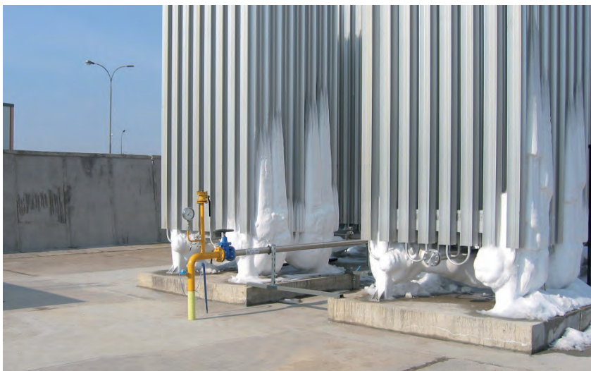
Rys. 4. Obmarzanie parownic [8]
