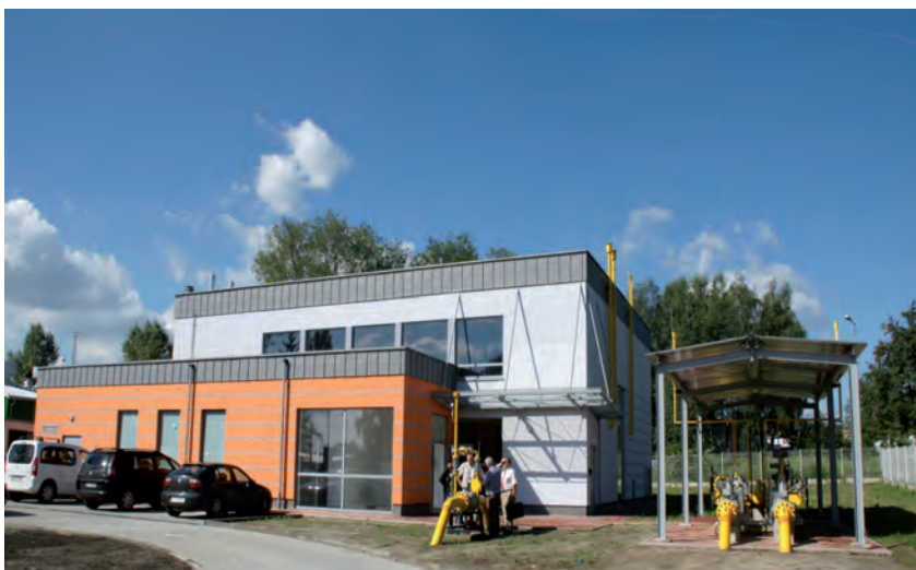
Ilustracja 2. Stacja Kraków-Zawiła po modernizacji
