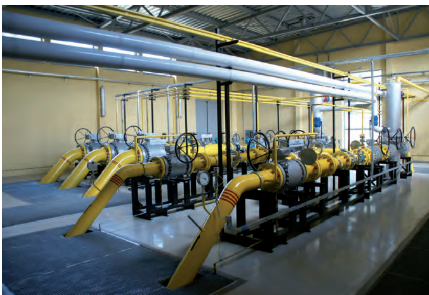
Ilustracja 6. Ciągi pomiaru technologicznego DN 200
